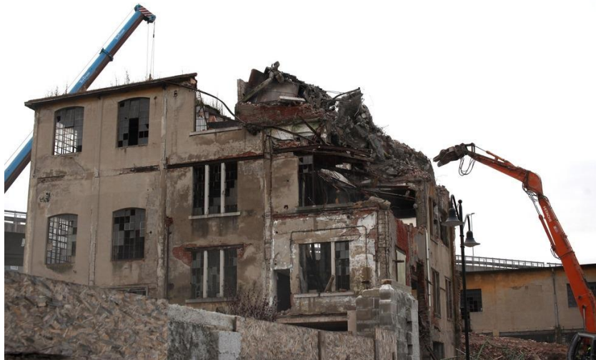
Abbattimento dell'Ex Opificio Gaslini - Pescara 28 novembre 2014
